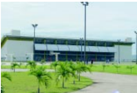
Construcción de tres polideportivos.
